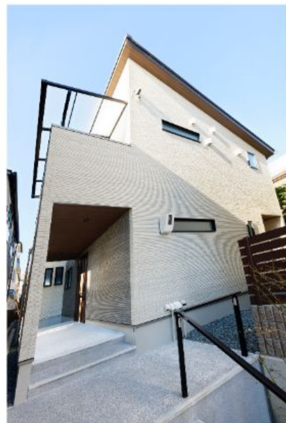
南側から太陽の光が降り注ぐ、明るい建物になりました
