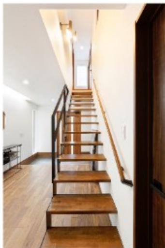
アイアンのスケルトン階段にすることで、玄関に階段を設けてもすっきりと開放的な印象に。
